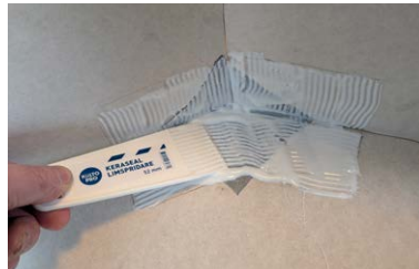
Sprid ut Kiilto KeraSeal med Kerasafe limspridare.
