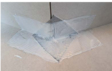
Kiilto KeraSeal ska finnas på hela ytan för Kiilto KeraSafe Ytterhörn.
