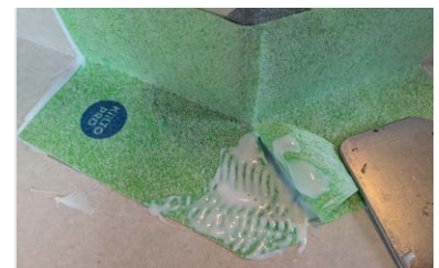
Vik upp överlappningen och applicera Kiilto KeraSeal enligt bilden.
