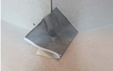
Fäst Kiilto Butyltejp på väggen diagonalt mot hörnet.
