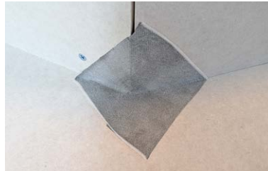
Tryck sedan fast Kiilto Butyltejp på väggen – pressa från hörn och vinklar ut mot kanterna och slutligen på golvet.
