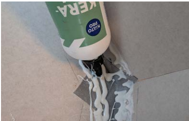
Applicera rikligt med Kiilto KeraSeal ovanpå Kiilto Butyltejp.
