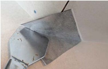
Tvinga Kiilto Butyltejp runt hörnet utan att fästa den i golvet.
