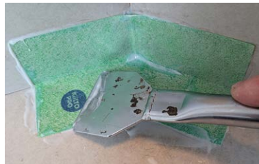
Pressa fast Kiilto KeraSafe Ytterhörn enligt bilden.
