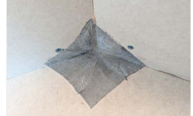
Ta bort skyddspapperet. Tryck sedan fast Kiilto Butyltejp på väggen – pressa från hörn och vinklar ut mot kanterna och slutligen på golvet. Bearbeta eventuella veck varsamt.
