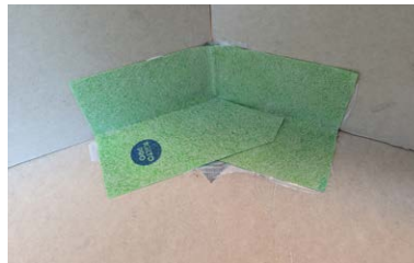
Montera Kiilto KeraSafe Ytterhörn enligt bilden.
