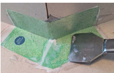
Pressa fast Kiilto KeraSafe Ytterhörn enligt bilden.
