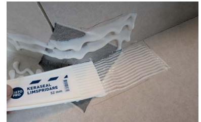
Sprid ut Kiilto KeraSeal med Kerasafe linspridare.
